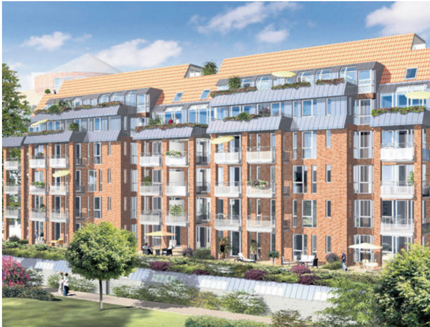
Beständige Baustoffe: Verblendziegel, Zinkflächen, Glas und Edelstahl bestimmen das Bild der Fassaden (hier die Südseite).
