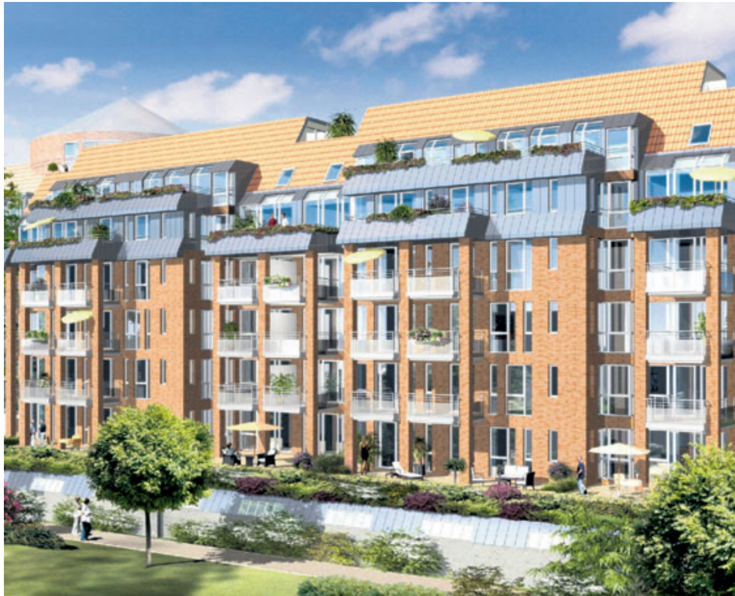
Beständige Baustoffe: Verblendziegel, Zinkflächen, Glas und Edelstahl bestimmen das Bild der Fassaden (hier die Südseite).
